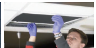
Einlegerahmen einsetzen
