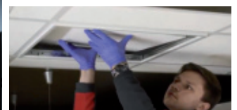
Deckenplatte wieder einlegen
